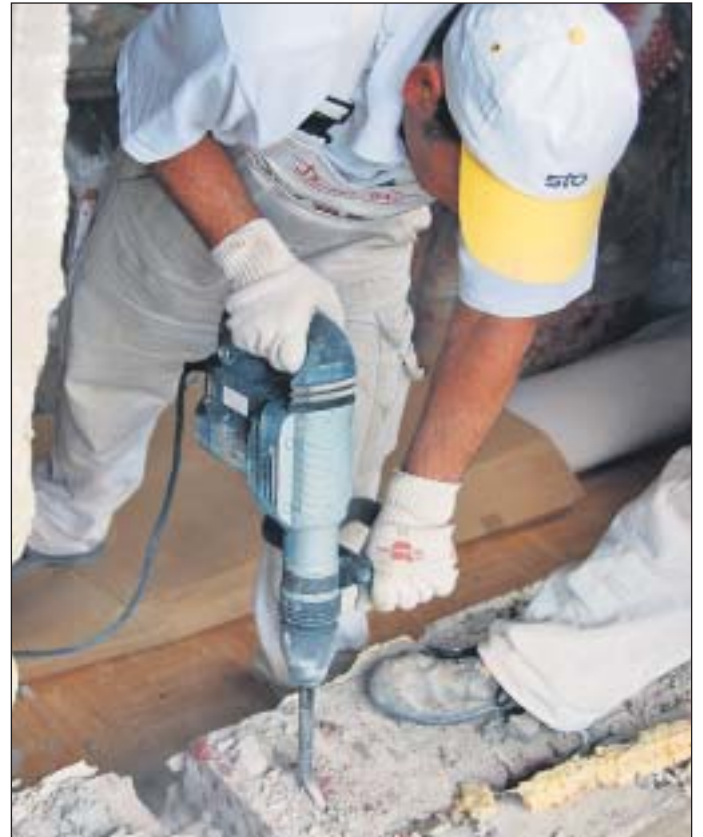
Reparatur- und Bauarbeiten können auch mal Lärm verursachen. Foto: WGF
