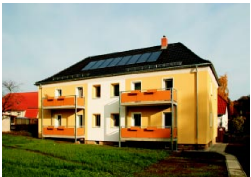
Solarmodule dominieren das Dach der Kirchstraße 20
