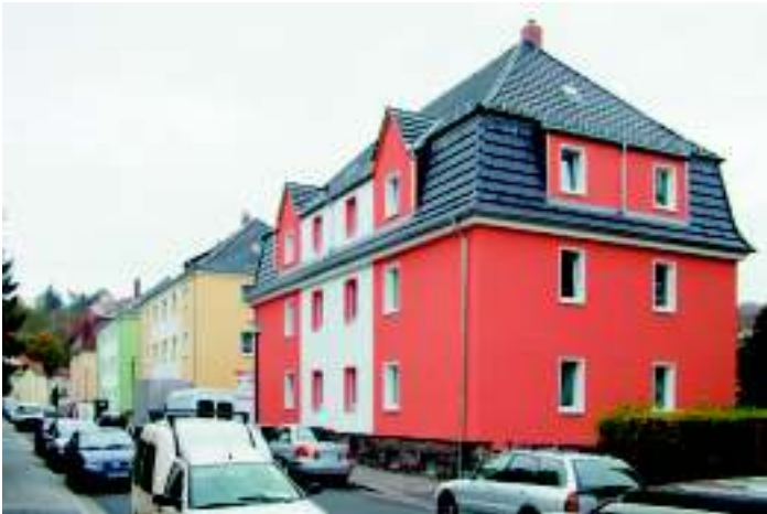
Brahmsstraße 4, 6 und 8 nach der Sanierung
