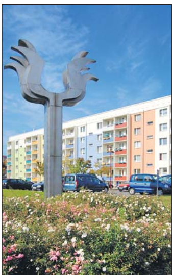
Das Karree Ringstraße in Zuckerode wurde aufwändig saniert. Foto: WGF
